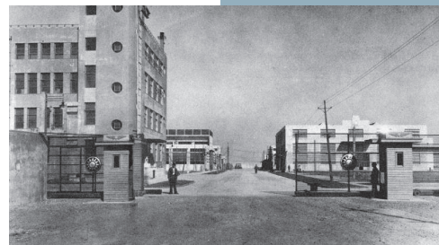
In alto, la fabbrica della S.I.N.A.W. in costruzione sul terreno della palude di Poyang, scelta per ragioni strategiche e di vicinanza all'aeroporto di Nanchang. A causa del forte tasso di umidità di questa zona paludosa (foto sotto) fu necessario installare impianti di drenaggio delle acque e sistemi di condizionamento dell'aria. In basso, l'ingresso della fabbrica. Costruito in meno di due anni, l'insediamento industriale italiano era uno dei più moderni realizzati in Cina
